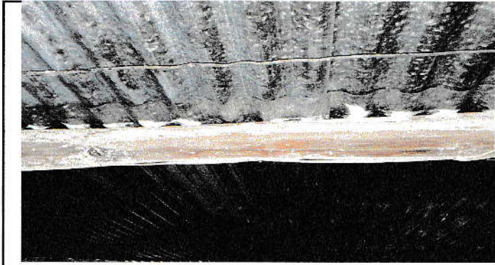
Foto 1: Sustitucion de lamina por lamina troquelada calibre 36
