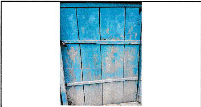
Foto 3: Sustitucion de puerta
